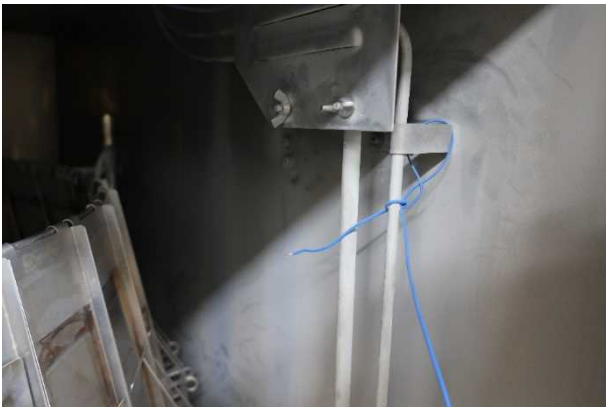
図 4 熱電対の設置
