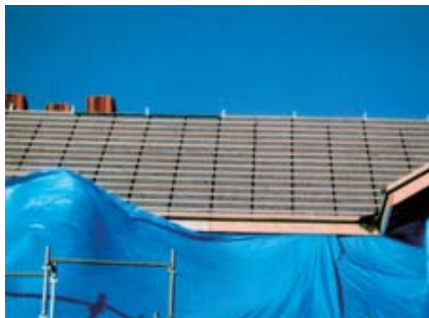
施工時の写真
